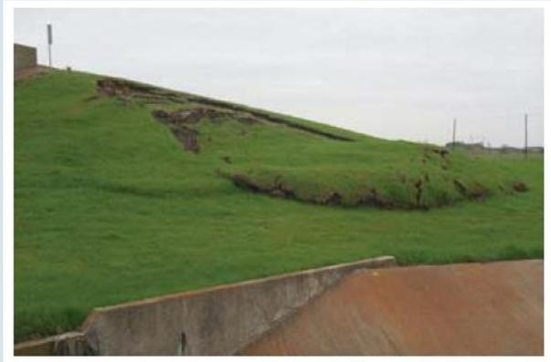
*Rupture progressive par fluage d'un sol argileux (CSTC)*
