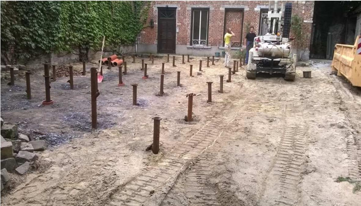
Forages pour cannes de chauffe et thermocouples
