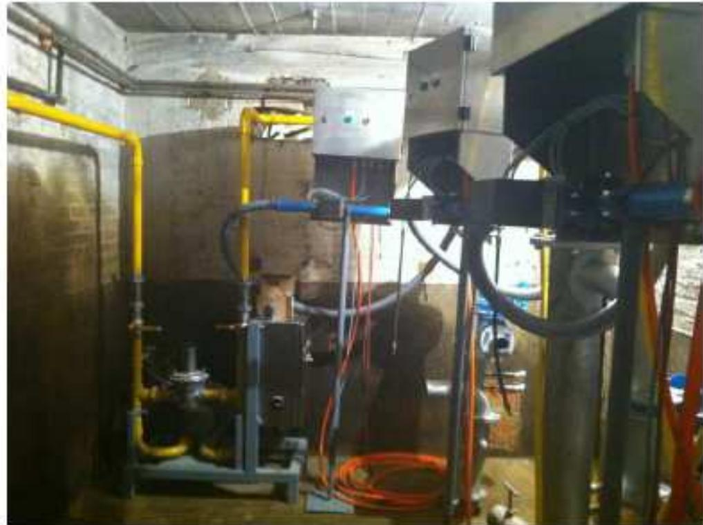
*Tubes de chauffe et connexion au réseau gaz de l'hôtel*
